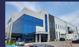
PLANT 5 인천 서구 [케이에스엠] 클리닝·코팅
